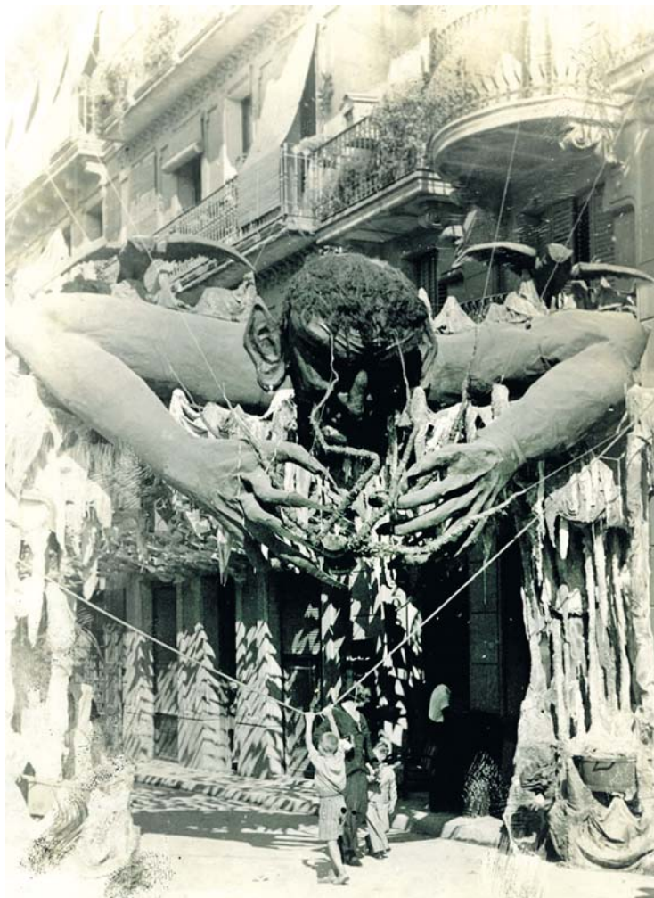
Guarniment del carrer de Ramón y Cajal el 1935. AMDG
